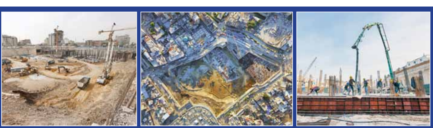
تصاویری از عملیات ساخت صحن حضرت زینب(س) در کربلا
