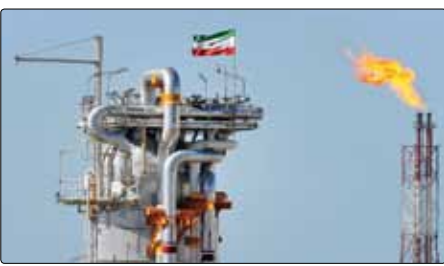
نمای کلی از خط انتقال گاز
