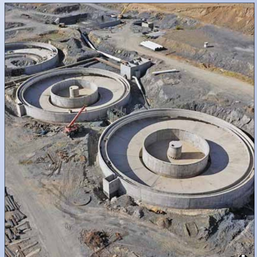
عملیات اجرایی آب‌رسانی از سد تالوار به شهر همدان
