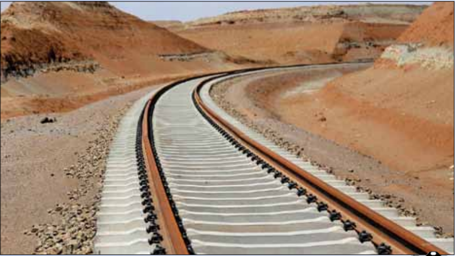
عملیات اجرایی راه آهن میانه-اردبیل
