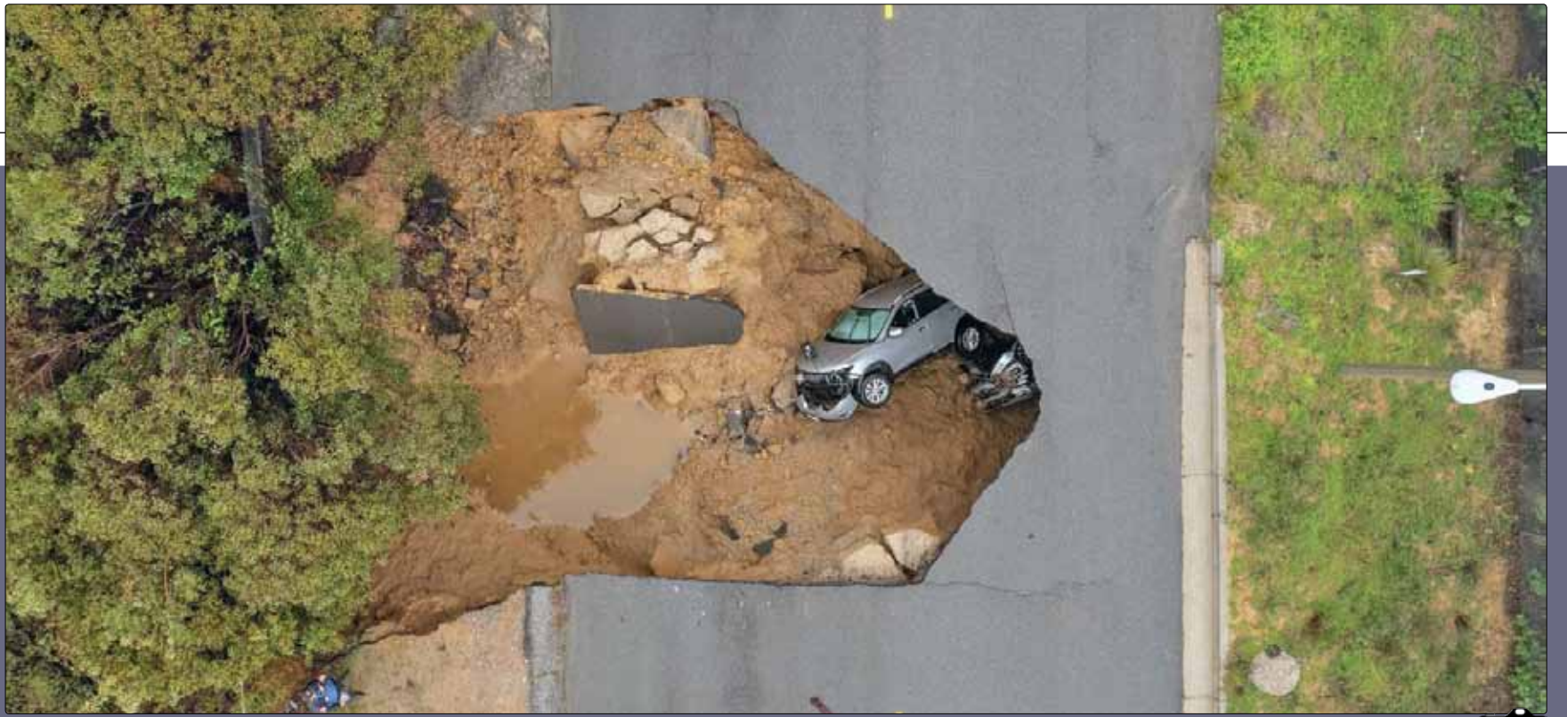
نمایی هوایی از ۲ خودرو که توسط یک گودال بلعیده شده‌اند / نیویورک - آمریکا
