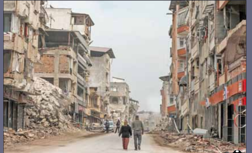
هزاران نفر در پی زلزله ترکیه و سوریه کشته و آواره شدند / هاتای - ترکیه
