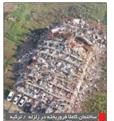
ساختمان کاملا فرو ریخته در زلزله / ترکیه
